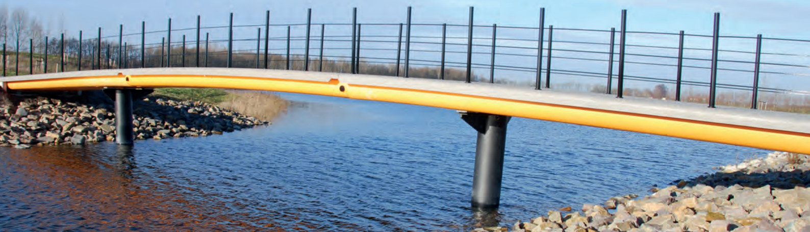
3-delige Urbanite Composietbrug 31.40x3.60 m (lxb) type UFCR te Emmeloord (Noordoostpolder) Ontwerp door Santman van Staaden Architecten
