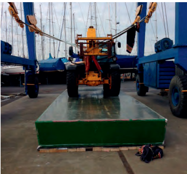
Belastingproef fiets-/voetgangersbrug
