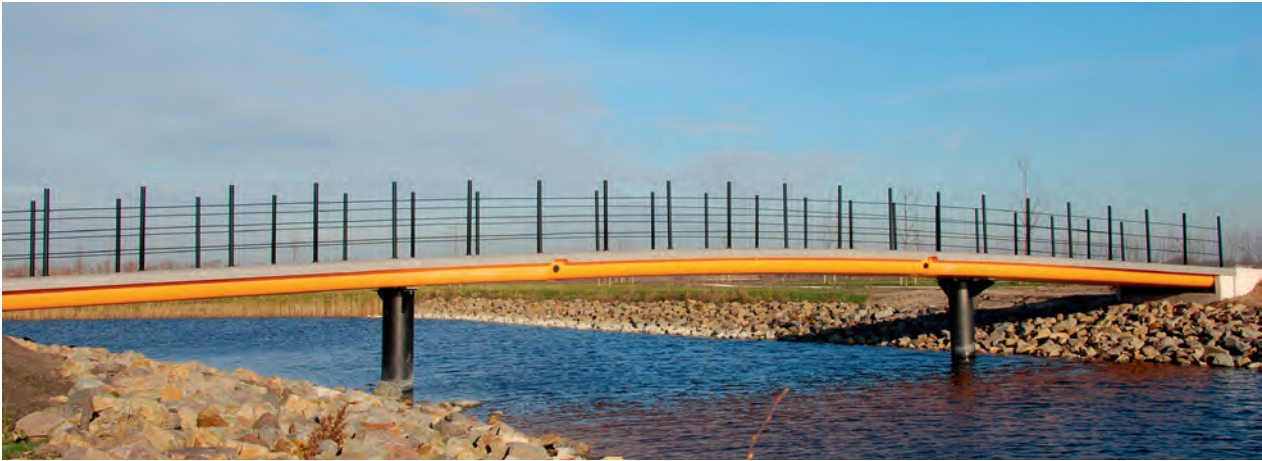
Zijaanzicht 3-delige Urbanite Composietbrug 31.40x3.60 m (lxb) type UFCR te Emmeloord (Noordoostpolder)
